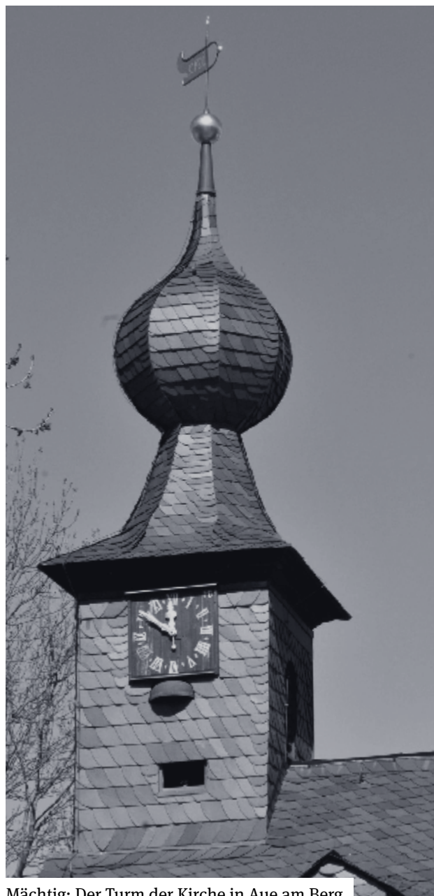
Mächtig: Der Turm der Kirche in Aue am Berg.
